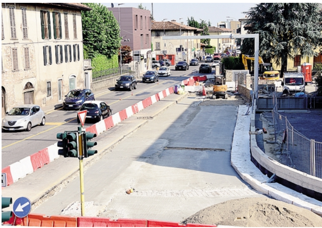
Lavori in corso per realizzare la seconda rotatoria a Ponteranica FOTO BEDOLIS
