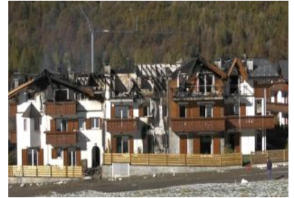
San Pietro I segni della distruzione dopo l'incendio
